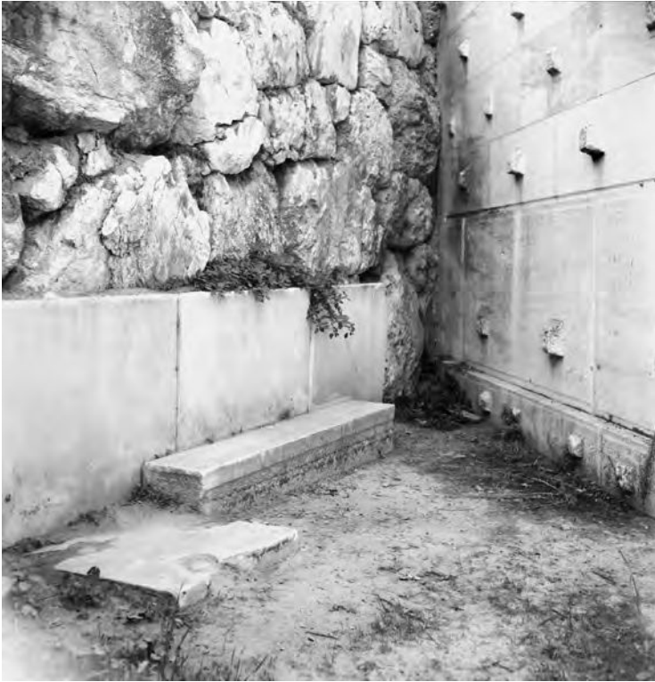
4 Resten van de Mykeense fortificatiemuur van de Akropolis, gedeeltelijk bekleed met marmeren platen.
