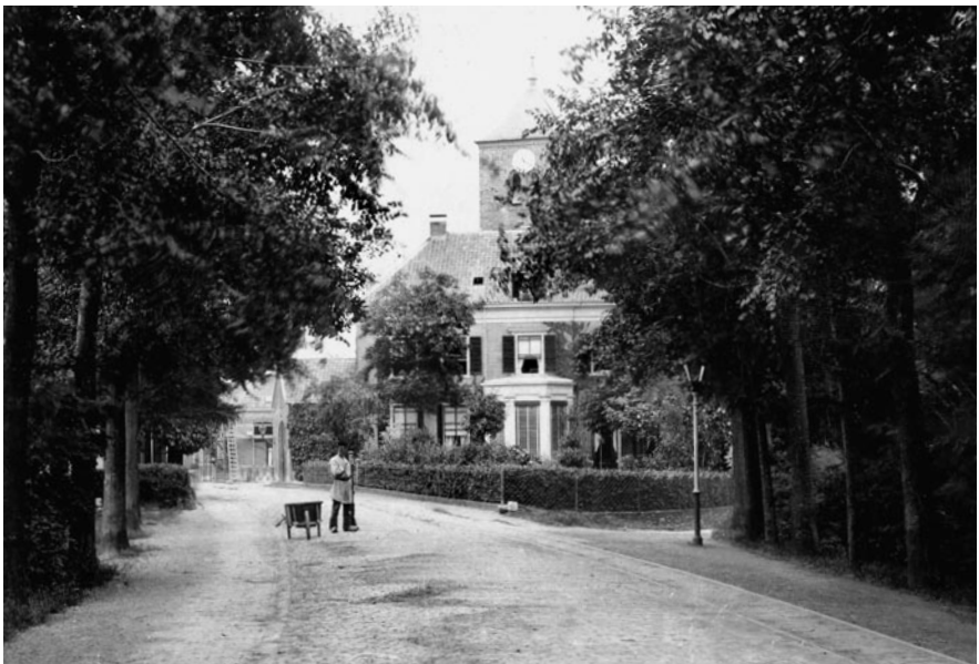
Warnsveld rond 1900. Aan het einde van de straat is het huis van meester Priems (dat in aanbouw is) nog net zichtbaar.
