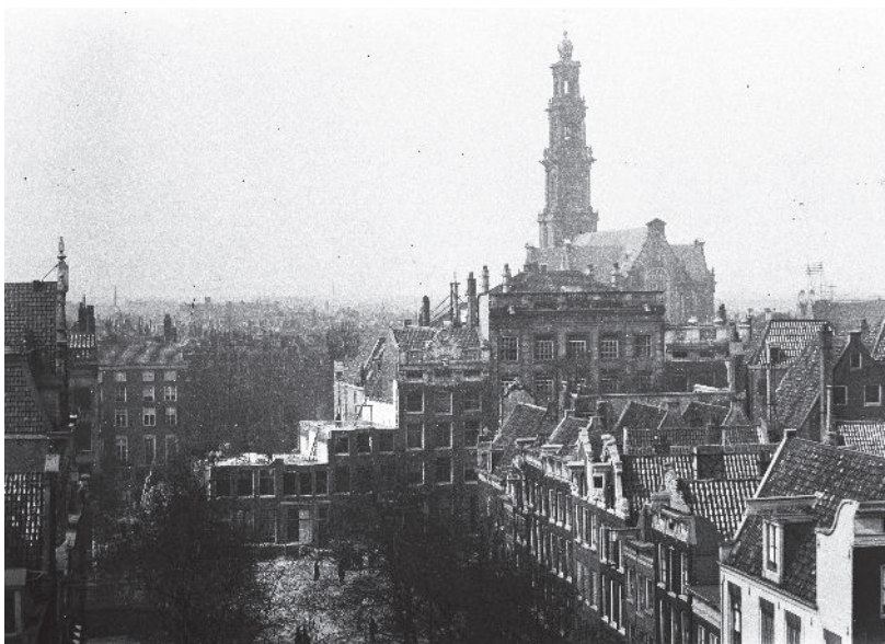
4. Afbraak van de huizen van de Heren- en Keizersgracht voor de aanleg van de Raadhuisstraat, op de voorgrond de gedempte Warmoesgracht, 1896. Foto Jacob Olie, Stadsarchief (afb.best. 10019A000170)
